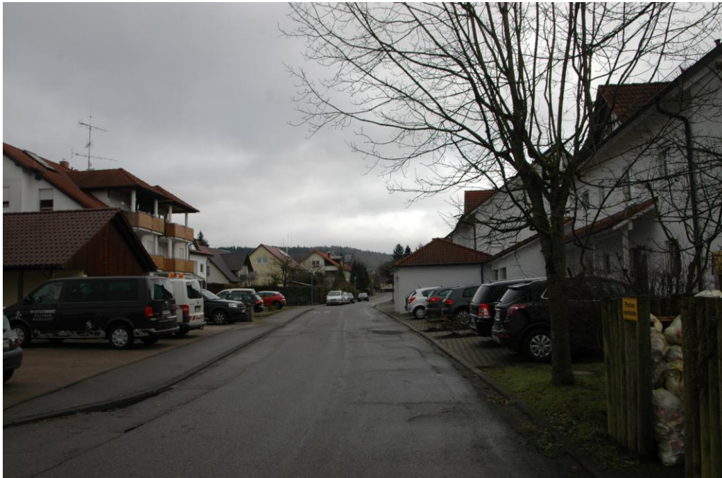
Blick von Westen in die Aachstraße
