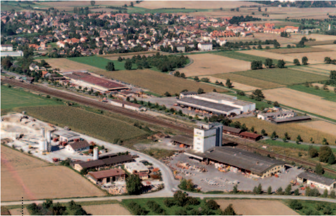
1985: Im Vordergrund ist das Kieswerk und die ZG zu sehen.
