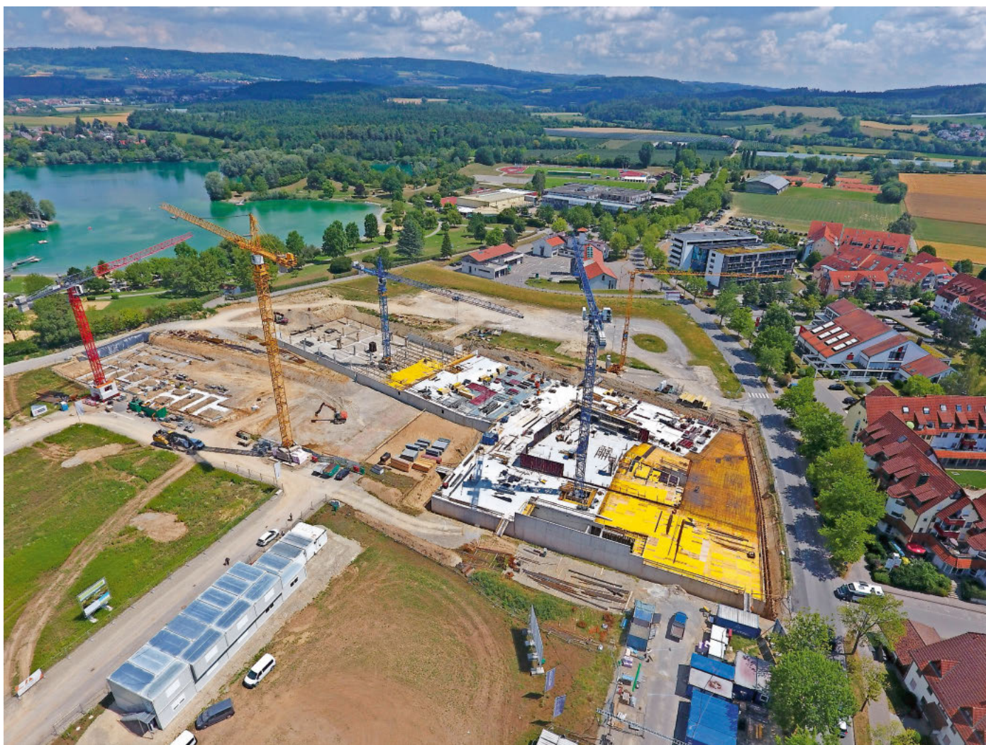
Auf der Baustelle in der Neuen Mitte wird aktuell die Decke über der Tiefgarage in einzelnen Abschnitten betoniert.
