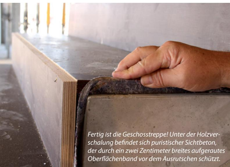
*Fertig ist die Geschosstreppe! Unter der Holzverschalung befindet sich puristischer Sichtbeton, der durch ein zwei Zentimeter breites aufgerautes Oberflächenband vor dem Ausrutschen schützt.*
